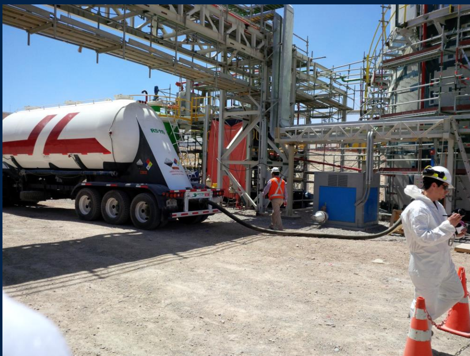
Ilustración 2: Carguío de cal viva desde camión al silo de almacenamiento de 750 [ton] de cal viva
