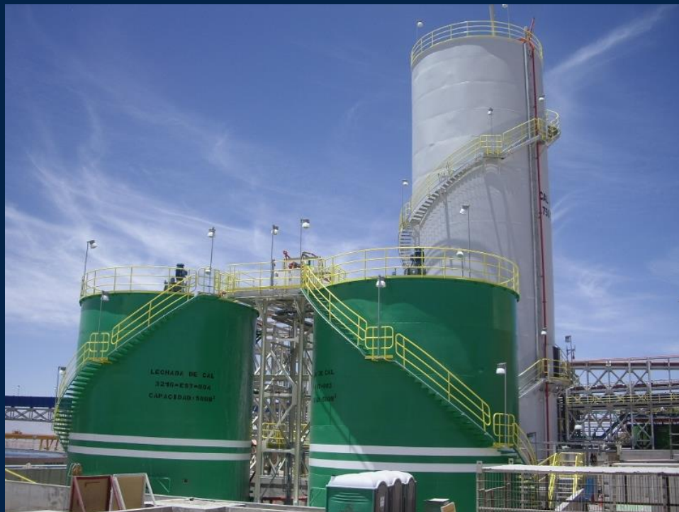
Ilustración 1: Vista general de la planta de preparación de lechada de cal CHEMCO y estanques de almacenamiento de lechada ya preparada.
