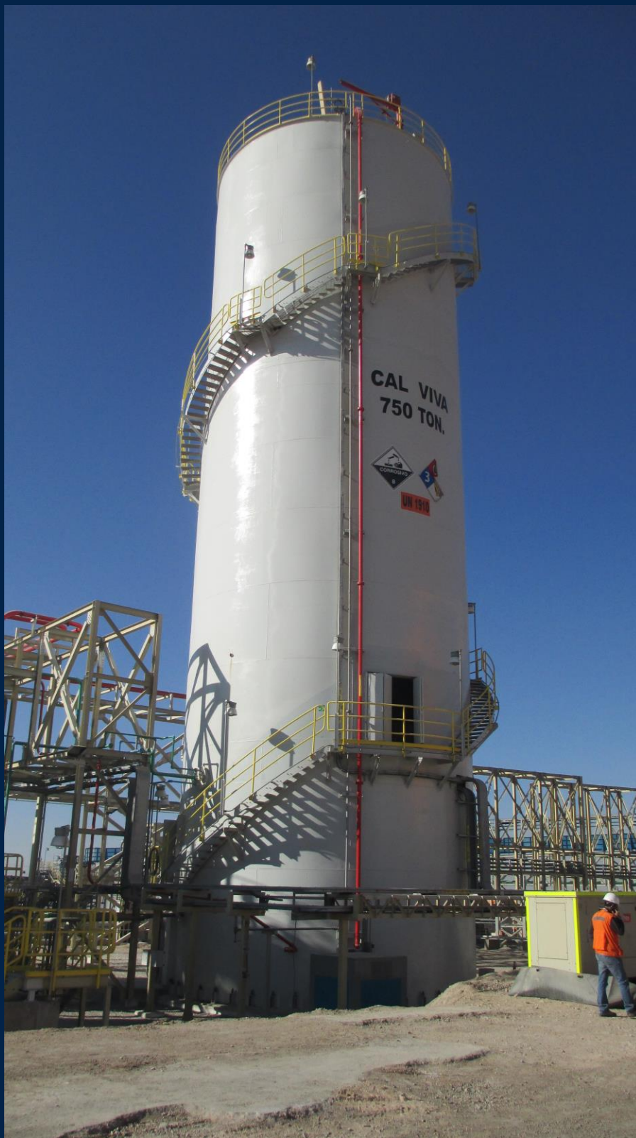
Ilustración 3: Vista del silo que contiene el almacenamiento de cal viva y los apagadores en su interior.
